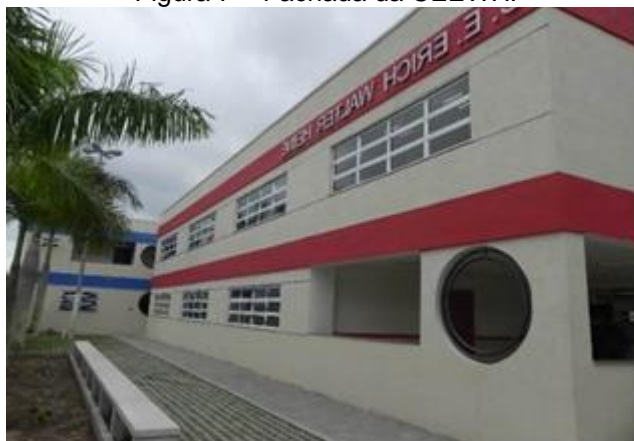
Figura 7 – Fachada da CEEWH.
