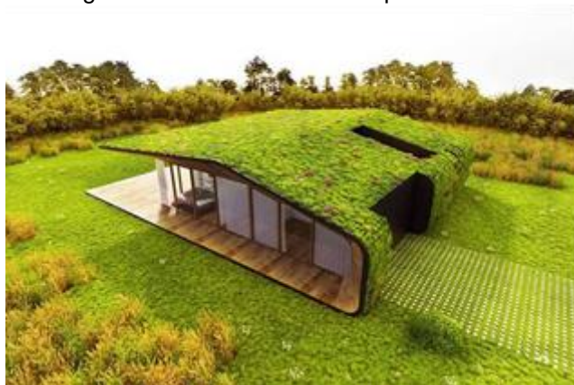
Figura 2 – Telhado verde do tipo extensivo.
