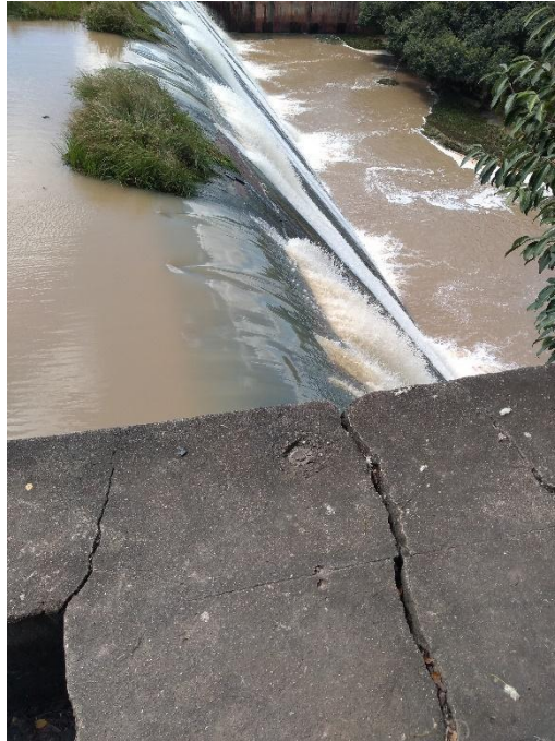
Figura 4 – rachadura encontra na coluna principal
