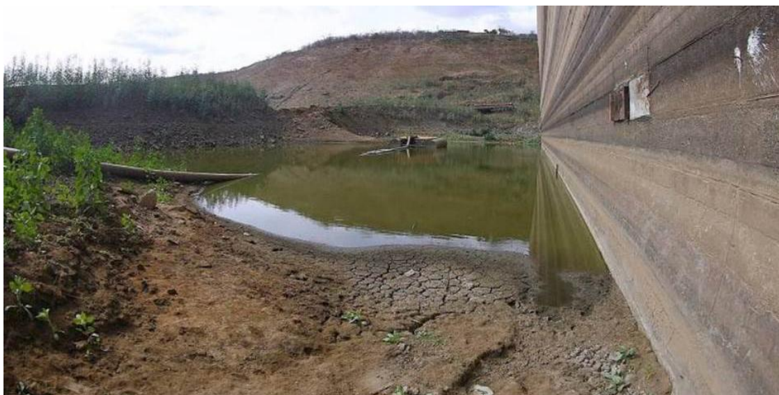
Figura 1 - Abandono e falta de monitoramento
