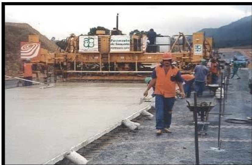
Figura 7: Pavimento rígido de concreto protendido
