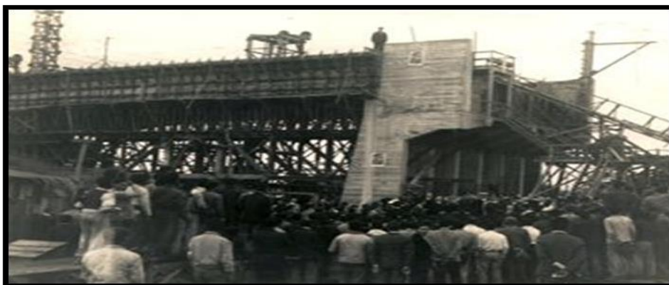
Figura 1: Construção da Ponte do General Uriburu na Argentina, meados de 1945.
