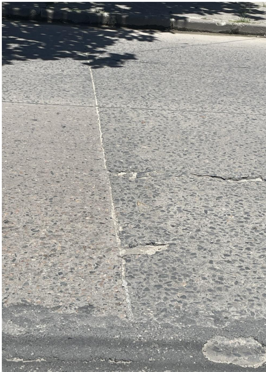
Figura 13: Fissuras Superficiais
