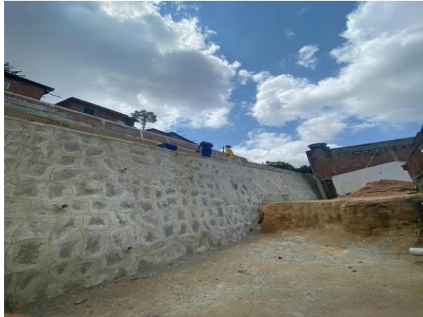
Figura 08 – Muro de pedra rachão em estudo
