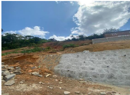
Figura 09 - Muro de pedra rachão em estudo
