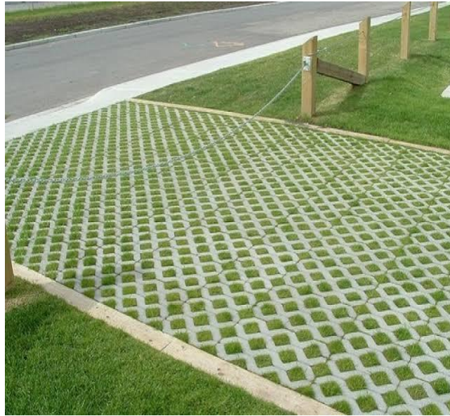
Figura 6 - Pavimento composto por blocos de concreto vazados preenchidos com grama.
