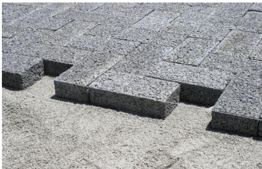
Figura 7 - Pavimento Bloco de Concreto Intertravado.
