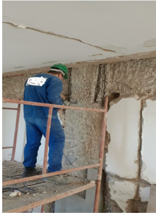
Figura 12 – Processo de escarificação realizado para reforço de armaduras atingidas pela carbonatação
