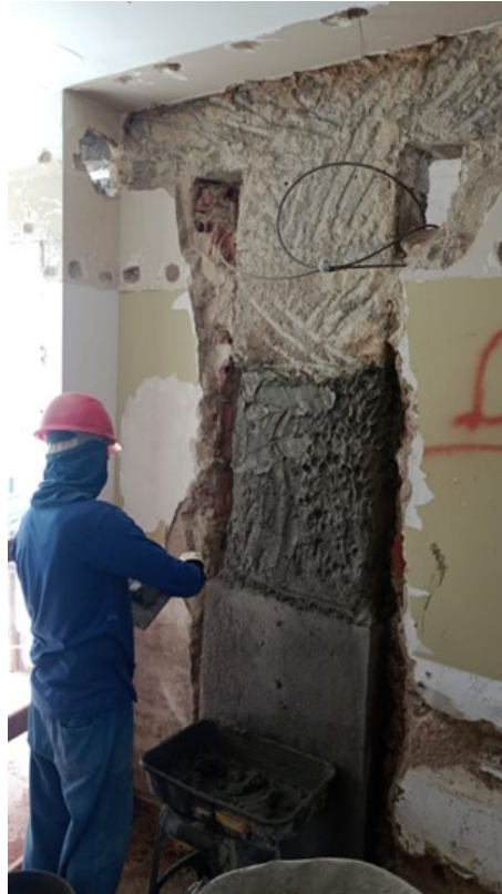
Figura 14 – Realização de fechamento de áreas reforçadas conforme a necessidade vista pela empresa com graute
