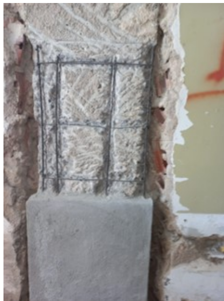
Figura 13 – Reforço de armaduras em áreas atingidas pela corrosão gerada da carbonatação
