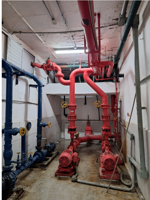
Figura 6 – Local abaixo do reservatório de abastecimento que foi realizado a análise de carbonatação
