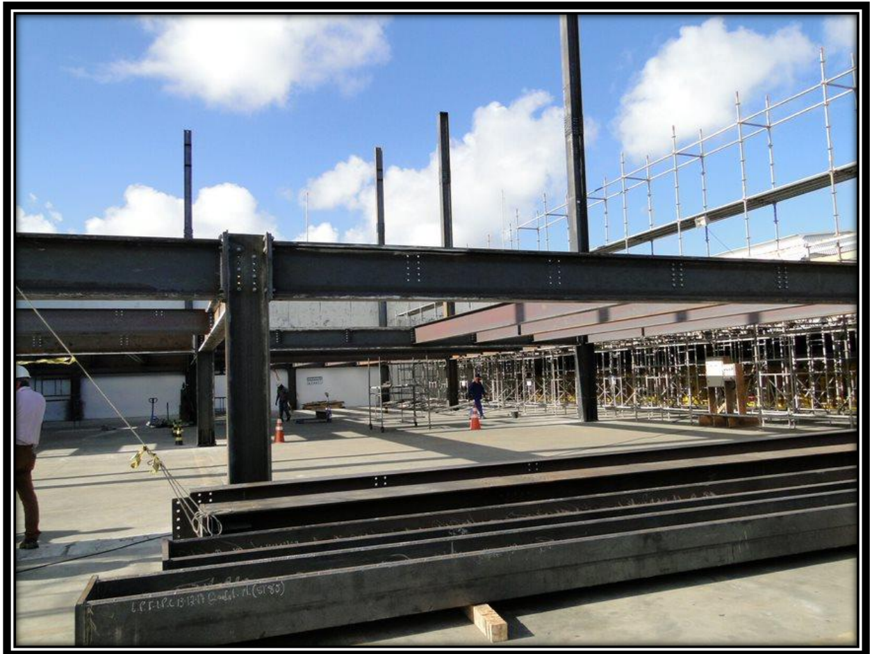
Figura 1 – Perfis de estrutura metálica, shopping Tacaruna Fonte: Autoral, 2018.
