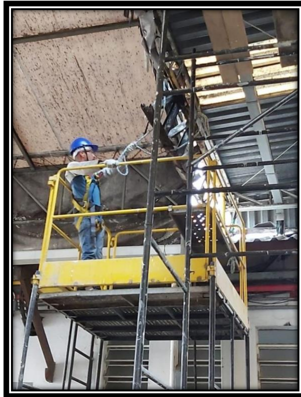
Figura 19 - Manutenção estrutural metálica
