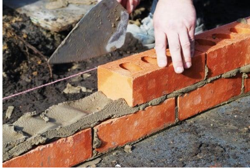
Figura 12 - assentamento de tijolos/blocos
