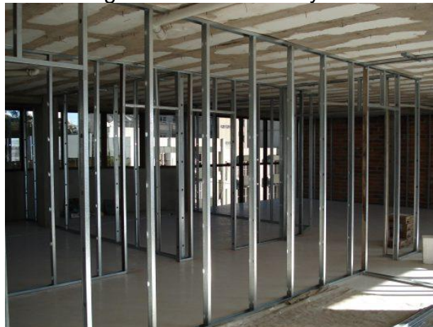
Figura 6 - Montante drywall
