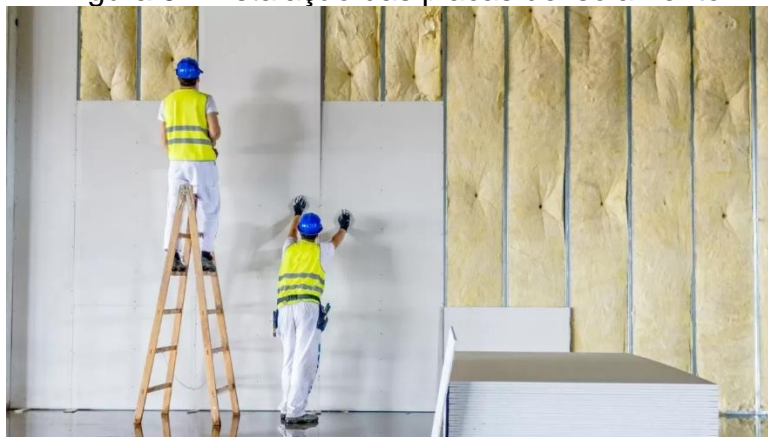
Figura 9 - Instalação das placas de isolamento
