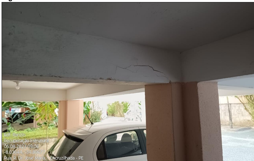
Figura 12 – Rachaduras
