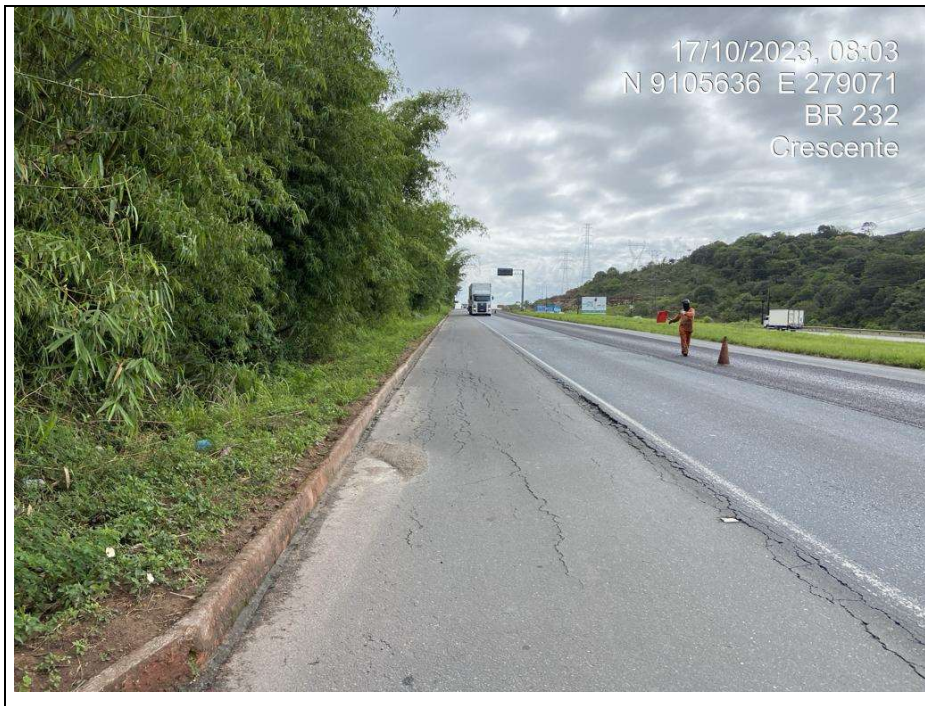
Figura 6 – Afundamento
