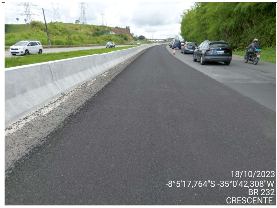
Figura 15 – Microrrevestimento Asfáltico a Frio 3.
