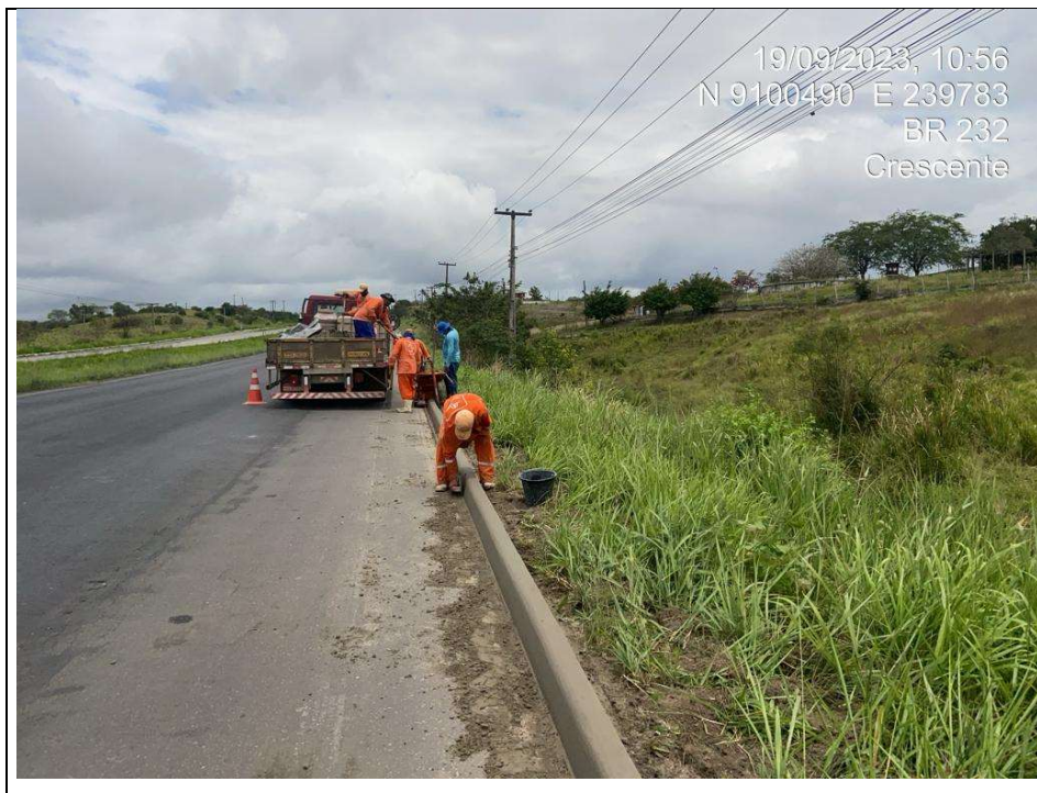
Figura 12 – Aprimoramento da Drenagem.
