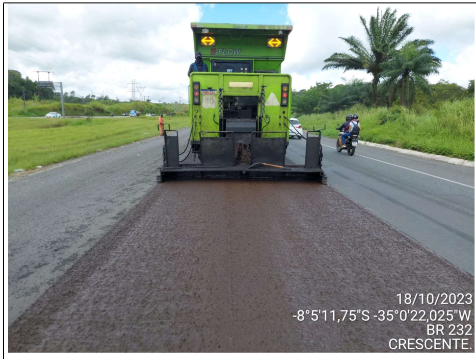
Figura 16 – Microrrevestimento Asfáltico a Frio 4.
