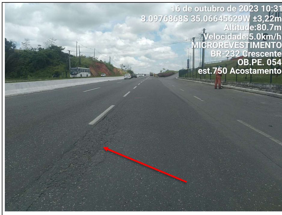
Figura 1 – Trincas Interligadas
