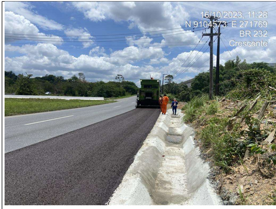
Figura 13 – Microrrevestimento Asfáltico a Frio 1.
