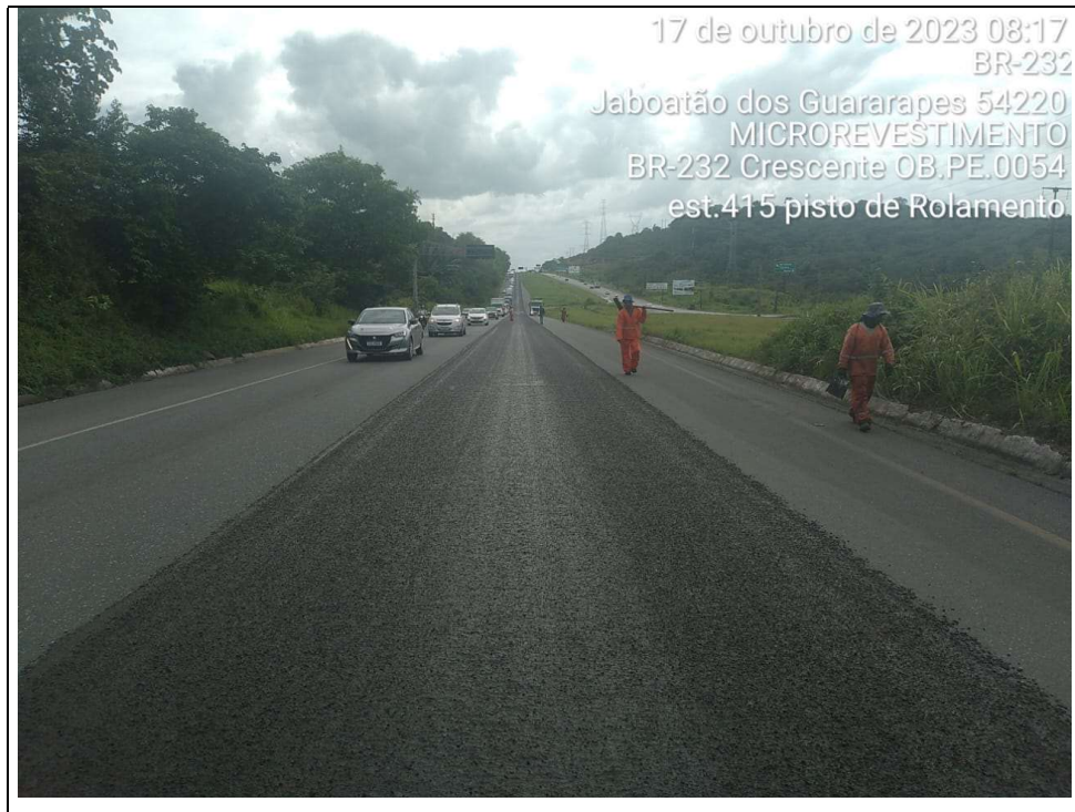
Figura 14 – Microrrevestimento Asfáltico a Frio 2.
