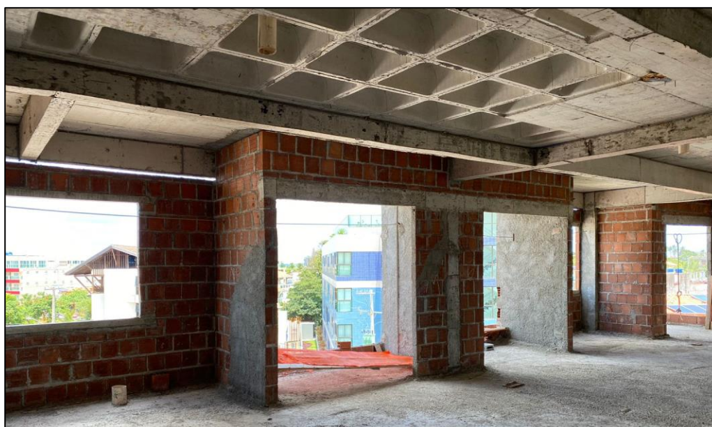
Figura 2 - Construção em estrutura convencional
