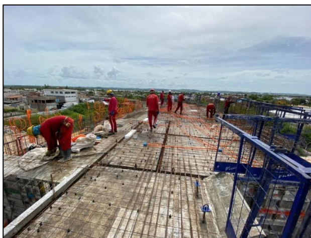
Figura 10 - Execução da armação das paredes de concreto moldadas in loco
