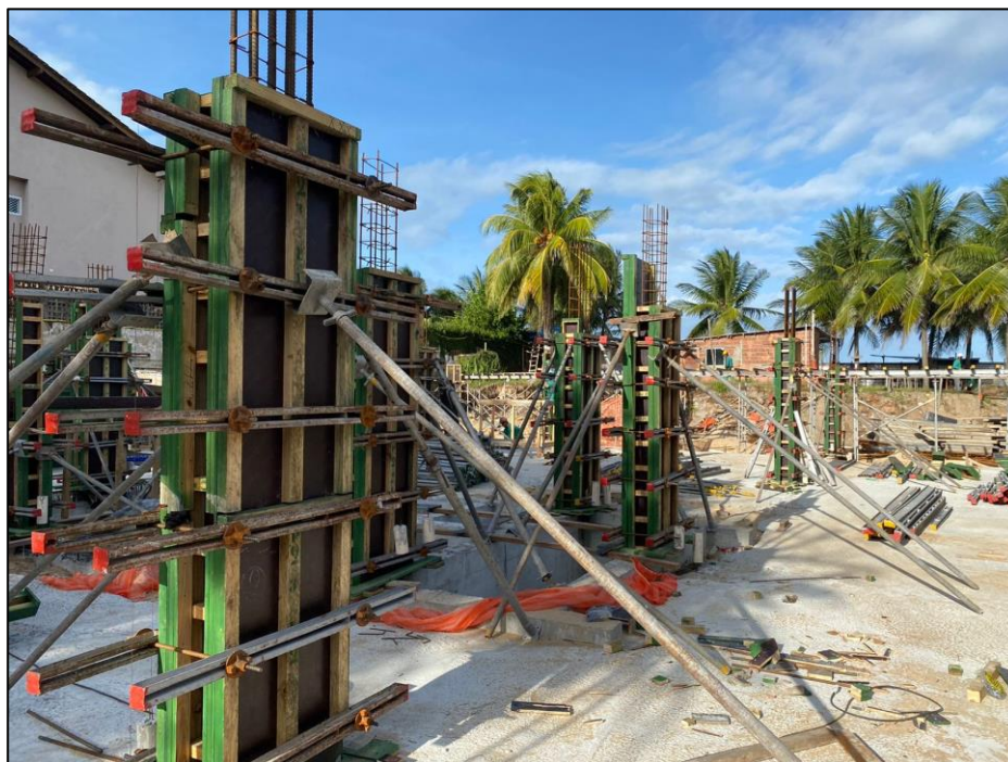
Figura 1 - Fôrmas dos pilares na estrutura convencional
