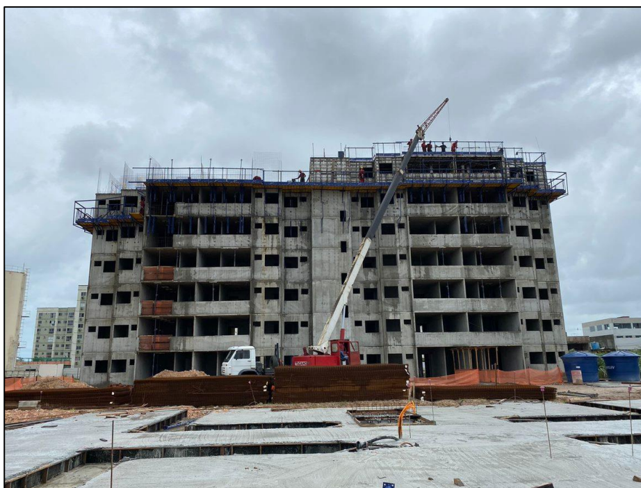
Figura 4 - Construção em paredes de concreto moldadas in loco
