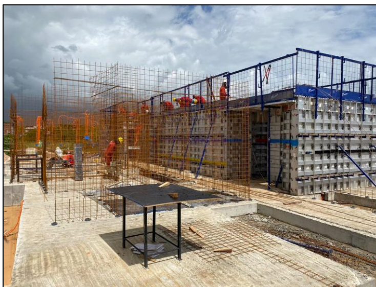
Figura 3 - Execução da estrutura em paredes de concreto moldadas in loco
