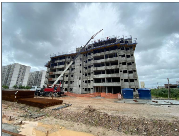
Figura 11 - Montagem de fôrmas das paredes de concreto moldadas in loco
