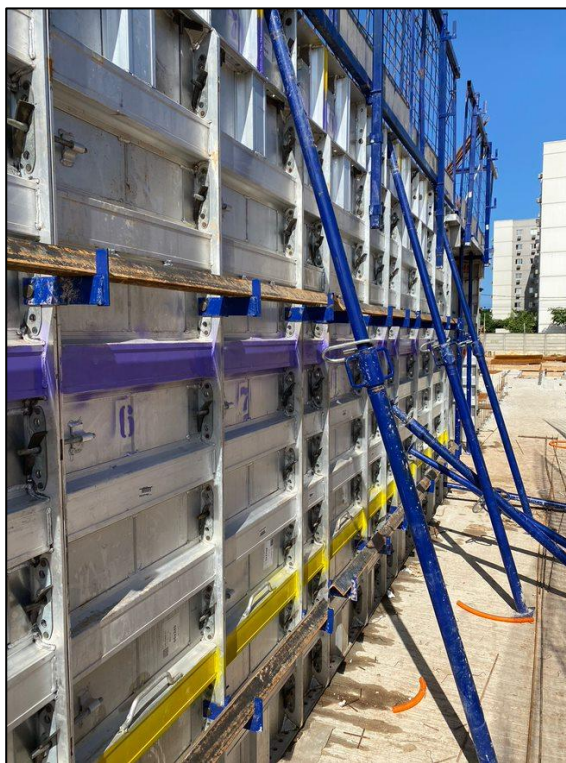
Figura 6 - Travamento lateral das fôrmas metálicas
