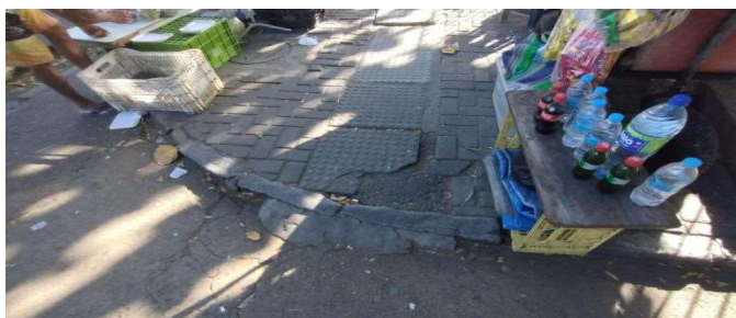
Figura 26 – Rampas inadequadas
