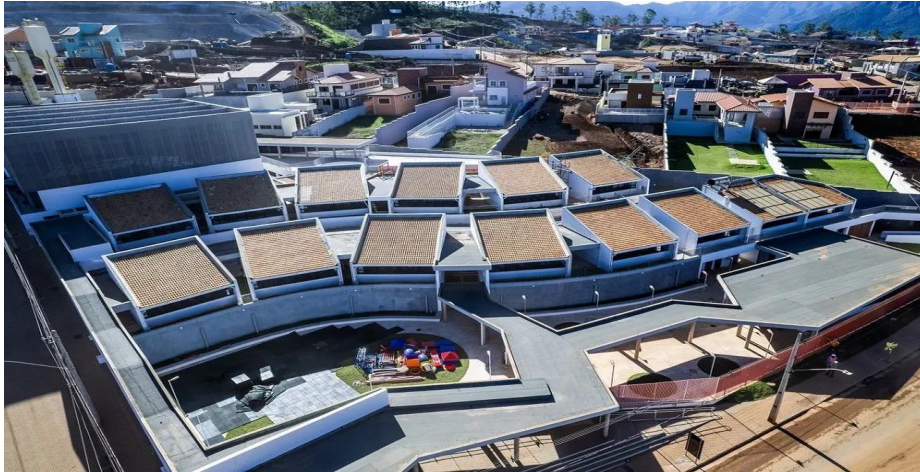
FOTO 5 - Escola municipal de Bento Rodrigues, construída no novo distrito.
