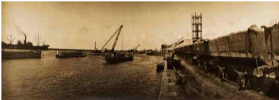
Figura 5 - Obras do porto do Recife 1911
