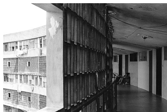
Figura 25: Fachada Vista Interna (cobogó)
