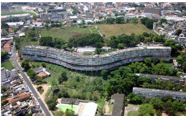
Figura 22: Edifício Forma Curva
