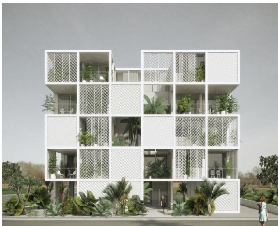
Figura 5- Edifício em Limassol
