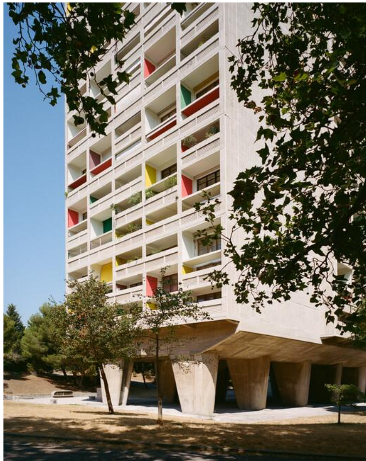
Figura 1 - Unités d’Habitation, em Marselha, França, por Le Corbusier. Fonte: Archdaily
