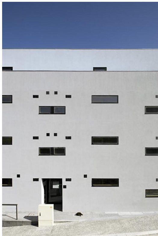
Figura 30 - Uma das fachadas do habitacional em Salgueiros. Fonte: Archdaily
