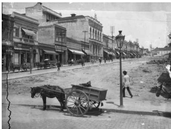
Figura 3: Casas após demolições para alargamento em São João – SP
