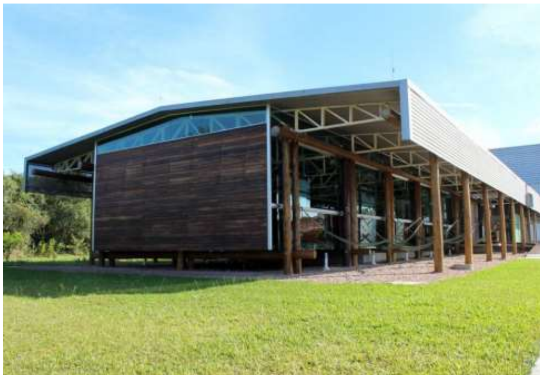
Figura 8 - Vista externa do Refeitório Anjo
