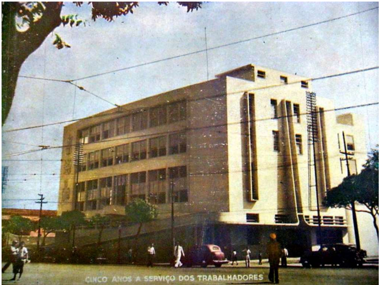
Figura 4 - Visão da Fachada do SAPS Central, na Praça da Bandeira.
