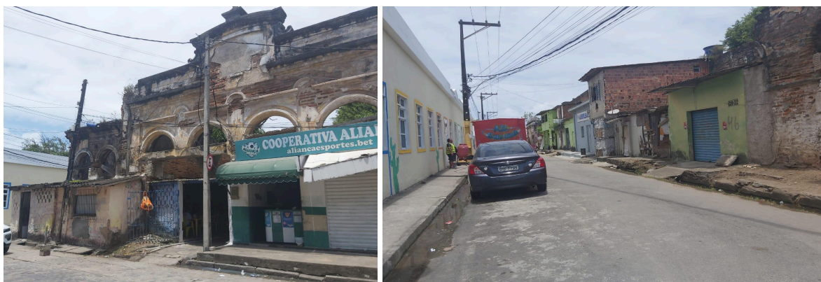
Fonte: A esquerda, Rua do Brum, Recife. A direita, Rua do Ocidente, Recife. Produzido pelos autores em 2023.
