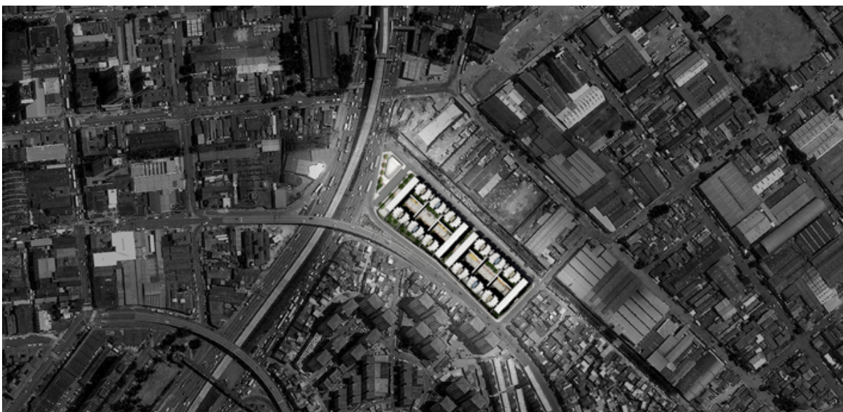
Figura 02: Vista aérea do jogo volumétrico do Conjunto Habitacional Heliópolis - Gleba G.
