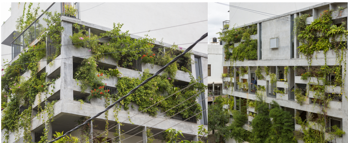
Figura 26: Vista Superior do Edifício Breathing Enclosure.
