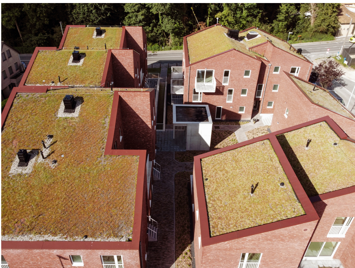
Figura 20: Vista aérea do Conjunto Habitacional de Waasmunster.
