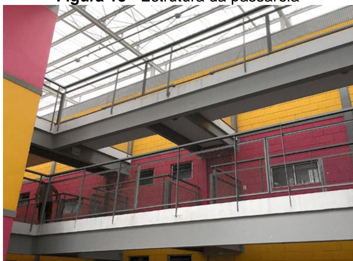
Figura 18 - Estrutura da passarela
