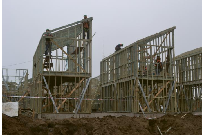
Figura 12 - Sistema wood frame
