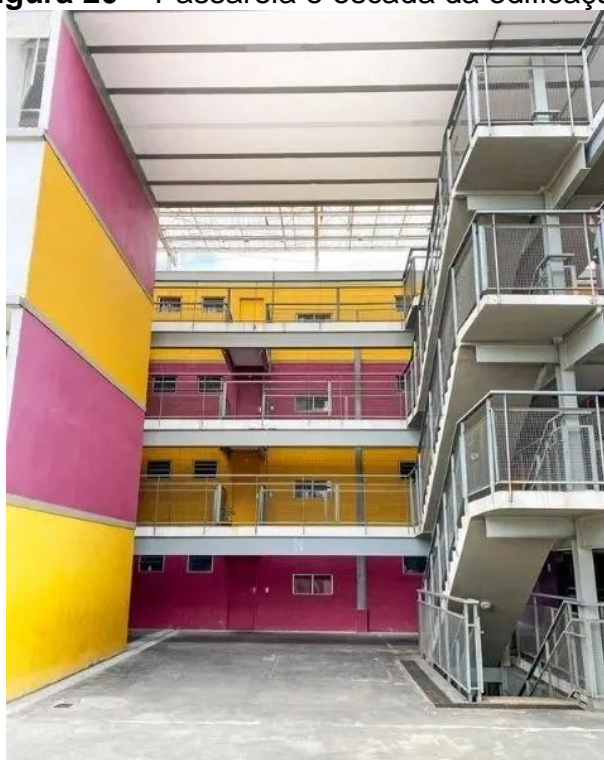
Figura 20 – Passarela e escada da edificação
