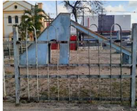
Figura 85 – Grades de proteção no playground.
