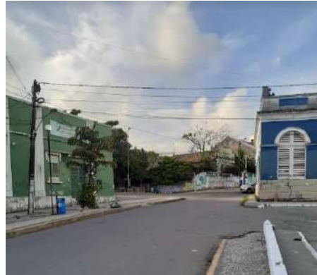
Figura 80 – Rua com o mesmo nível da praça.
