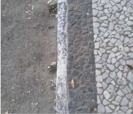
Figura 82 – Materiais do piso.
