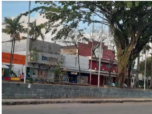
Figura 81 – Fachada principal com desnível.
