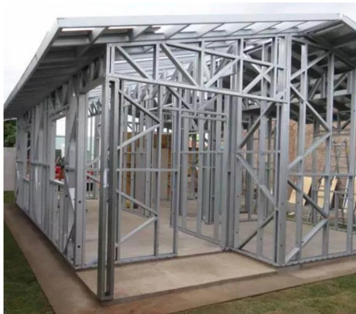
Figura 02- Detalhe esquemático de steel frame Fonte: GDSUL (2022)
