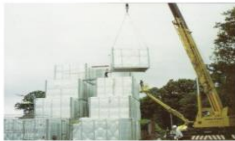
Figura: 9 - Montagem de estrutura por construção modular Fonte: TELL CONSTRUCTION INSTITUTE (2018)
