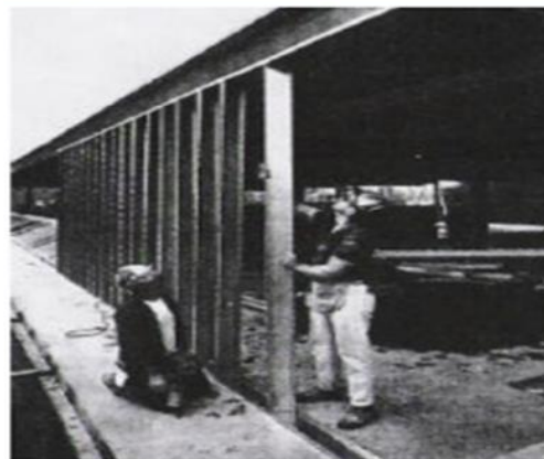
Figura: 6 - Montagem de estrutura método Stick Fonte Scharff (1966)
