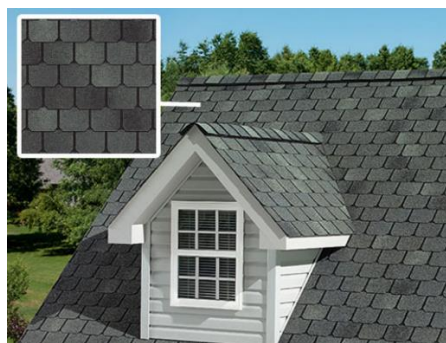
Figura:13 - Telhado shingle Fonte: Arquitetura em curitiba
