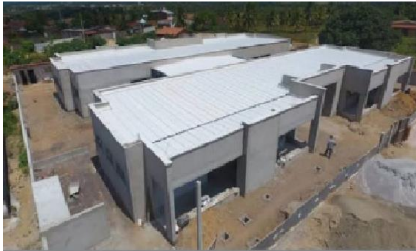
FIGURA 22 – Coberta concluída FNDE
