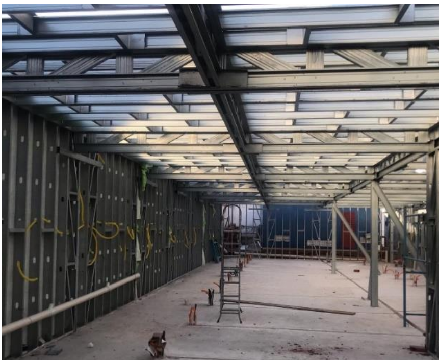
Figura 17- Estrutura do primeiro pavimento
