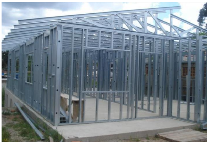
FIGURA 25 – Estrutura de Steele frame da residência do Sr. Orion
