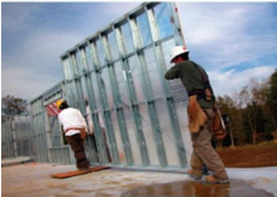
Figura:7 -Montagem de estrutura pelo método dos painéis
