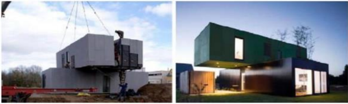
Figura:8 – Montagem de estrutura por construção modular Fonte: koma construction (2014)
