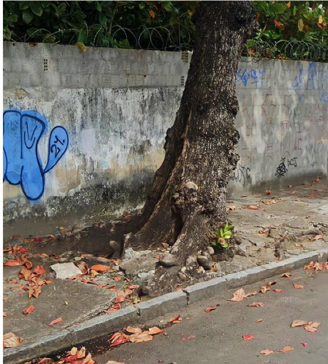
Figura 11: Raízes com plantio inadequado, Avenida Militar, Bairro Recife (1).
